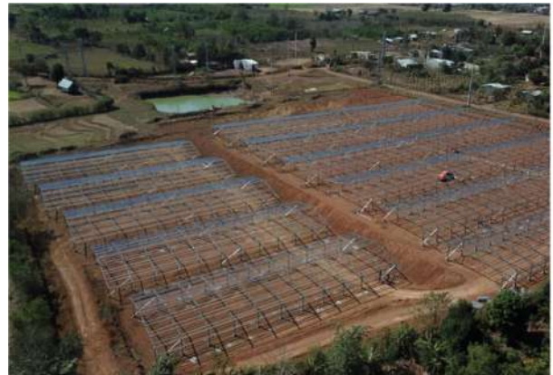
Lắp đặt hệ kết cấu nhà thép
