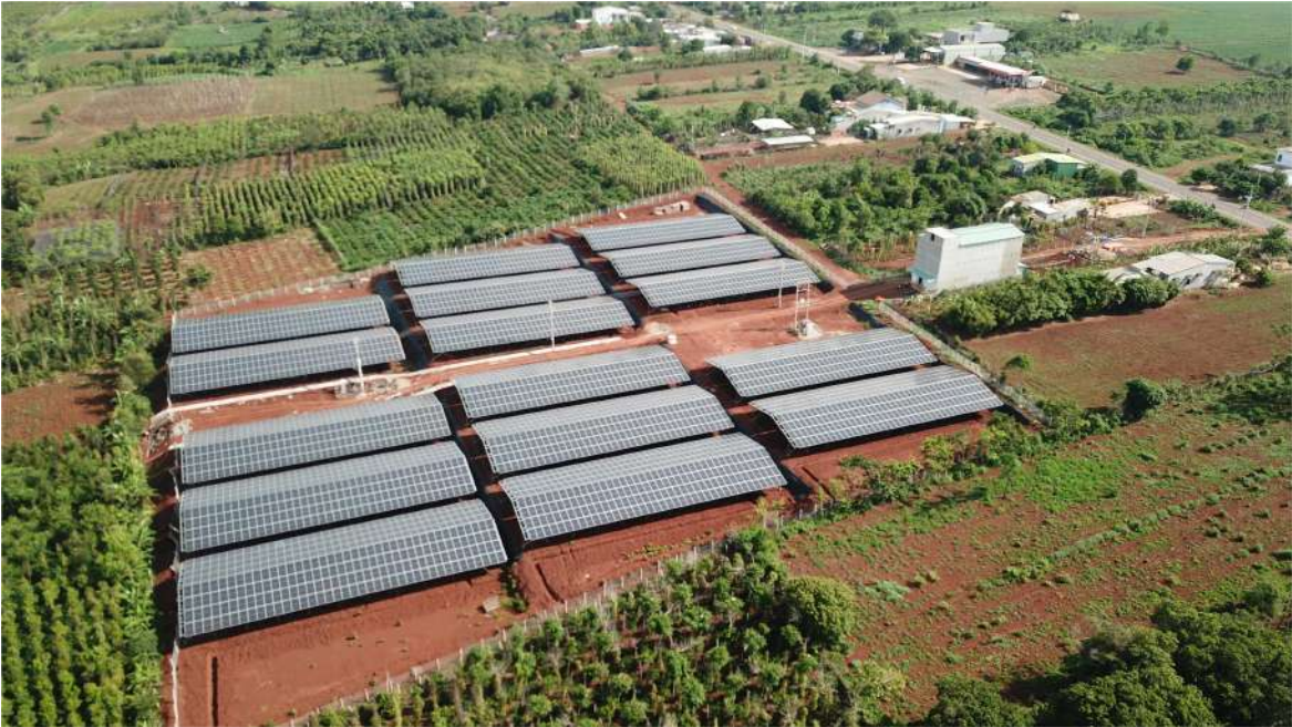
Một trong các dự án điện năng lượng mặt trời 998 kWp do SGR thi công đã hoàn thành đóng điện
