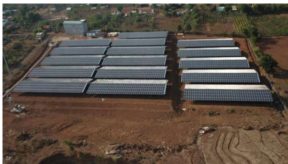
Một số dự án đã hoàn thành đóng điện vào lưới điện quốc gia do SGR làm tổng thầu
