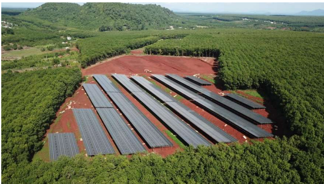
Dự án điện mặt trời áp mái ở Đức Cơ, Gia Lai
