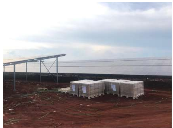
Lắp đặt tấm pin điện mặt trời
