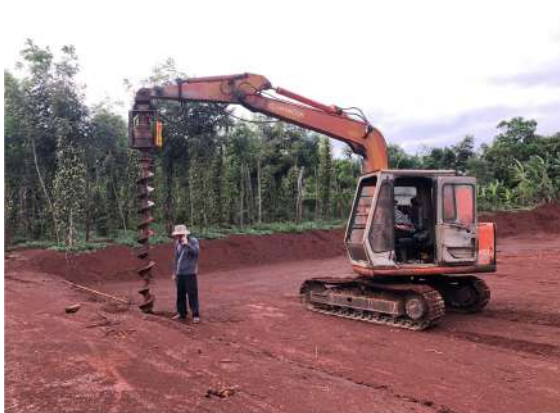
Khoan móng công trình
