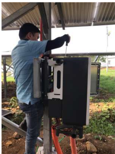
Lắp đặt Inverter
