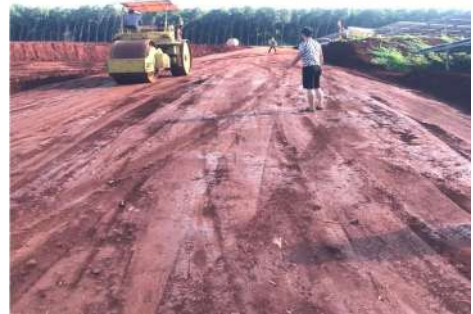
Thi công hạ tầng – san lấp mặt bằng
