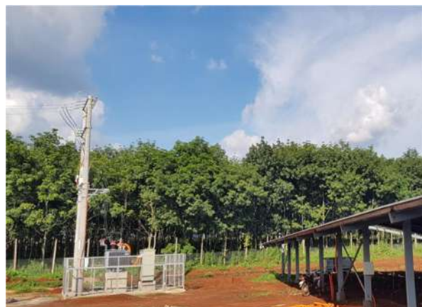
Lắp đặt Trạm biến áp
