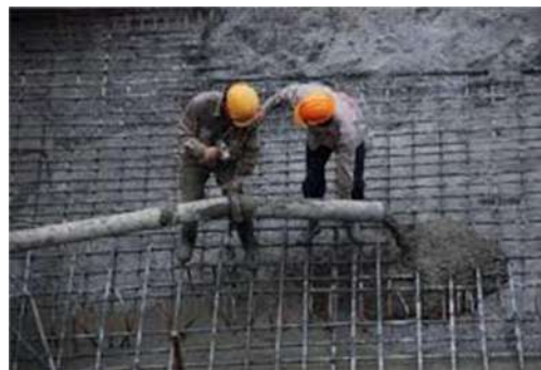
Thi công kết cấu các tòa nhà
